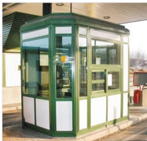
▼ granična kontrola, alumijska konstrukcija 3,0 x 2,4 m
