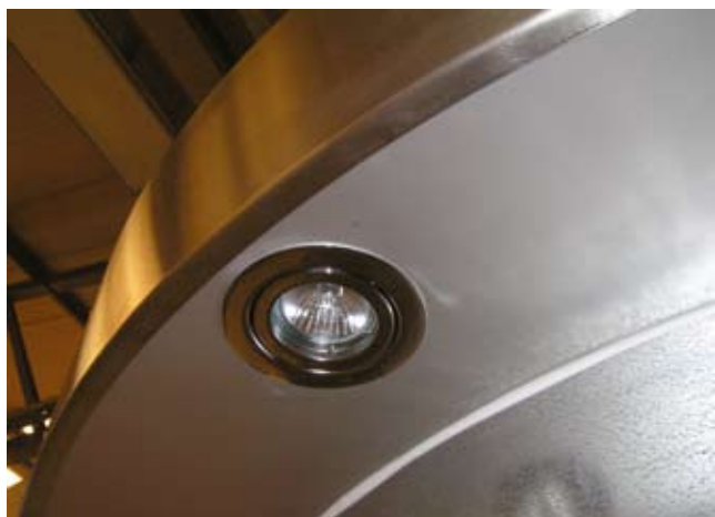
▼ halogena rasvjeta u inox kapi stupa
